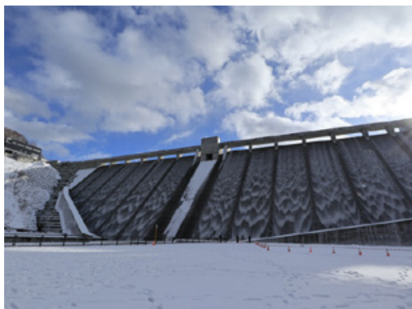
写真-13 サーチャージ水位到達時の状況①
