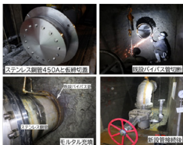
写真-6 ステンレス鋼管とモルタル充填状況
