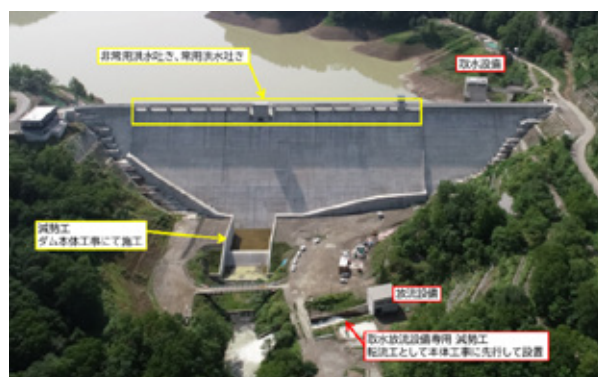
写真-5 新桂沢ダムの減勢工
