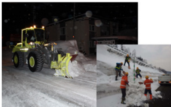
写真－1 深夜の除雪作業
