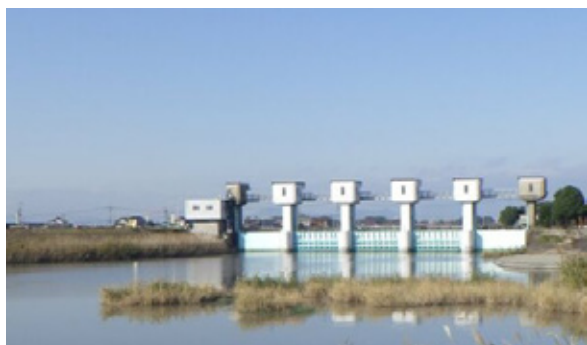
写真－１ 河川用ゲート設備
