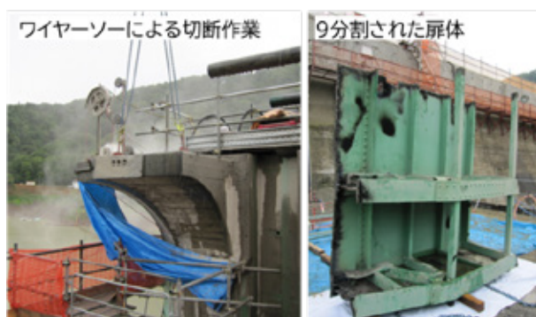
写真-9 分割切断状況
