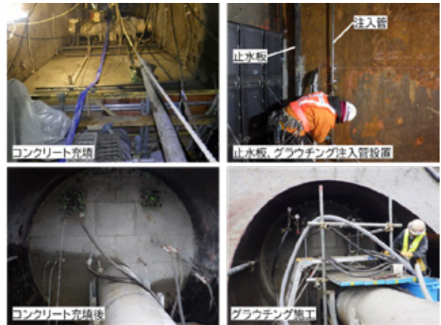
写真-8 コンクリート充填施工状況
