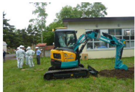
ICT建設機械(3DMCバックホウ)搭乗体験 〔協力：ニシオレントオール北海道〕
