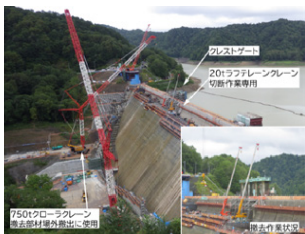
写真-12 クレーン配置状況
