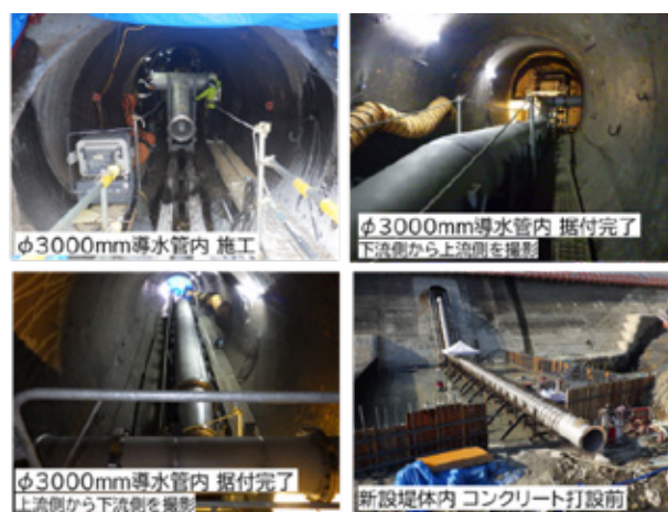
写真-7 堤体内水道導水管施工状況
