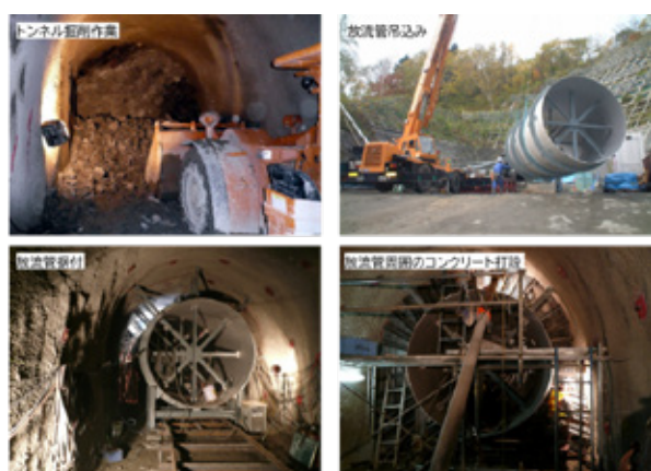
写真-4 導水路トンネルの施工状況
