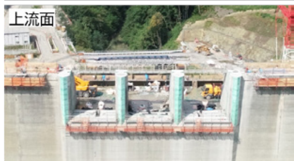
写真-11 既設クレストゲート撤去後状況
