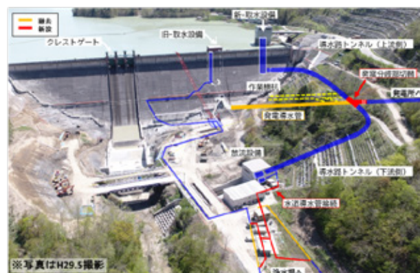
図－９ 取水放流設備 施工ステップ
