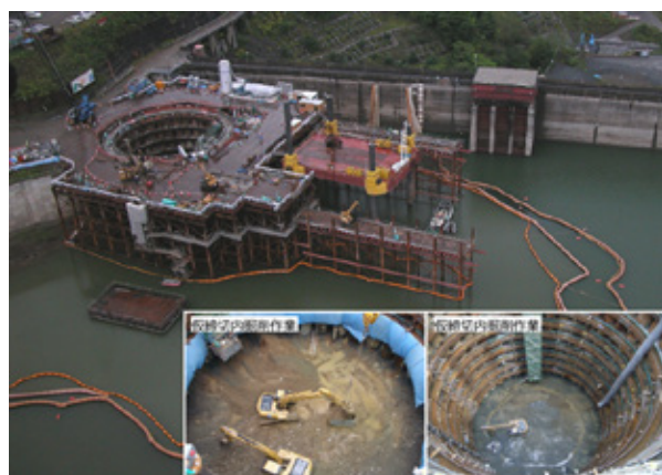
写真－2 取水設備施工状況
