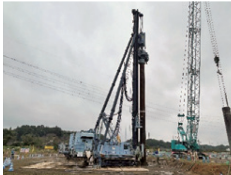
鋼管沈設（同時沈設）作業状況
