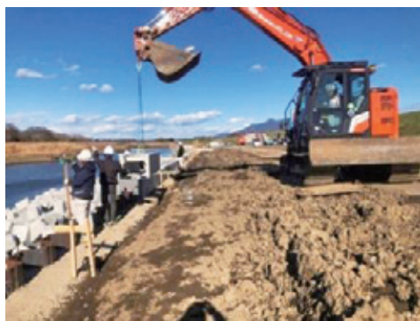
笠コンクリートブロック据付状況
