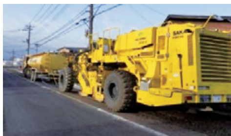
スタビライザによる破碎混合状況
