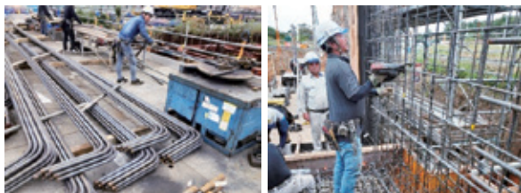
鉄筋の加工・組立状況
