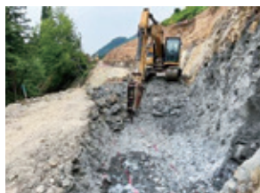
大型ブレーカ掘削
