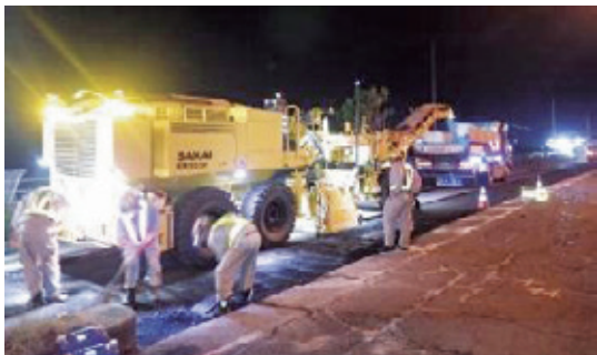
路面切削機（ICT）による切削状況
