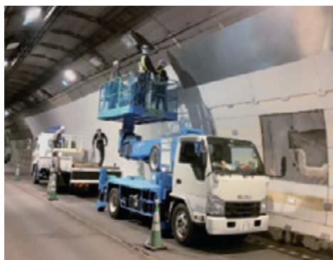
断面修復（左官工法）作業状況
