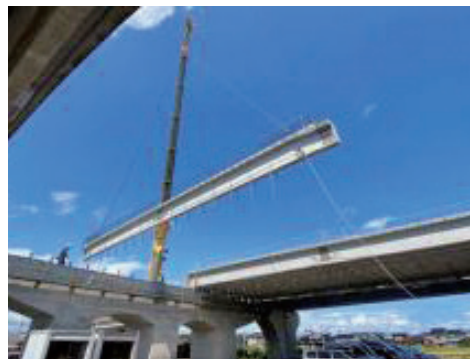
PC桁架設状況
