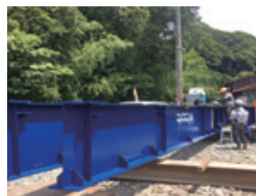
仮設鉄桁地組状況
