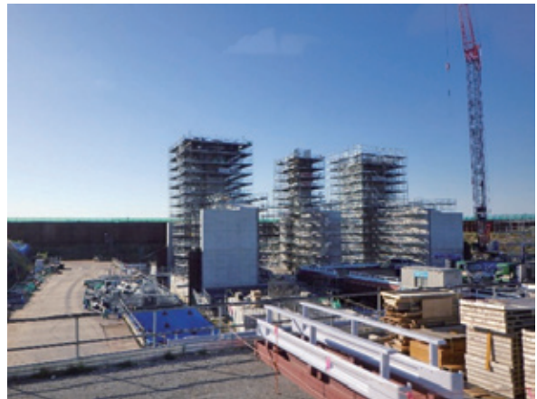
写真-7 北村遊水地排水門工事
