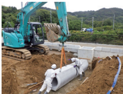
鉄筋コンクリート台付管据付状況
