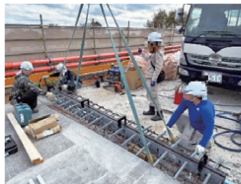
既製品ジョイント設置状況
