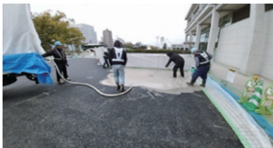
セメントミルク散布状況
