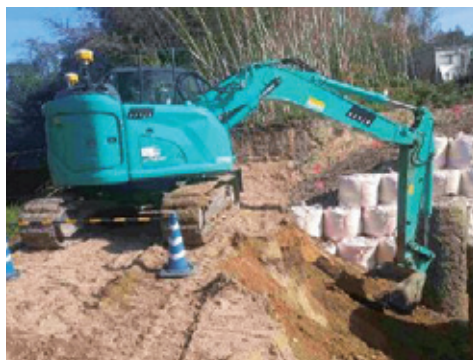
3DMCバックホウによる床掘状況
