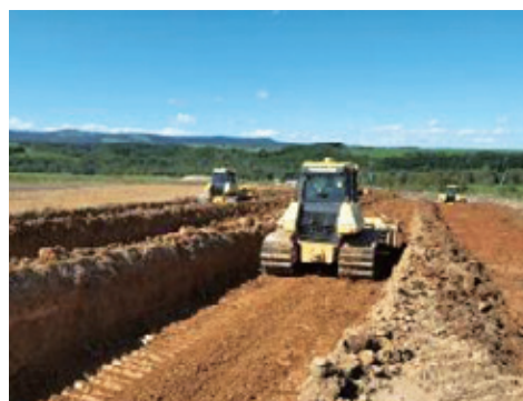
ブルドーザ施工状況
