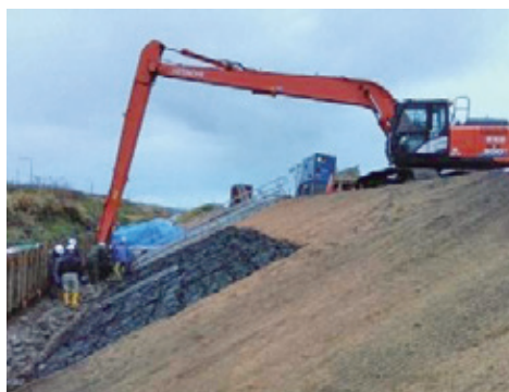
捨石投入状況（バックホウ超ロングアーム型）
