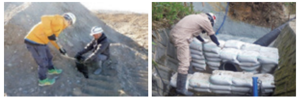
土のうの製作・積立状況
