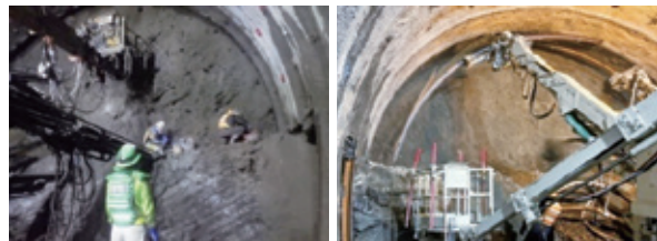
穿孔・装薬状況
