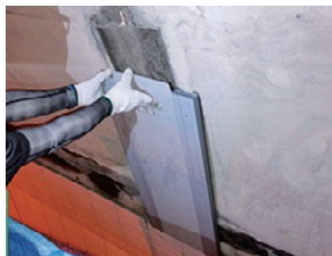
導水樋工作業状況
