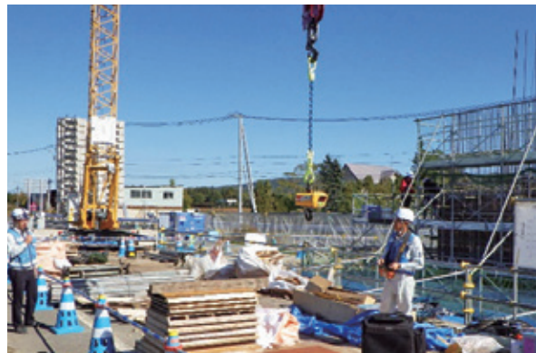
写真-2 操作状況
