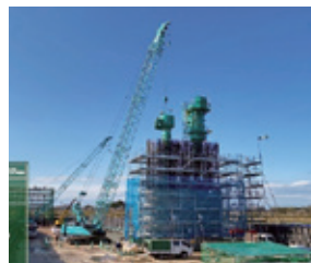
艀装設備組立
