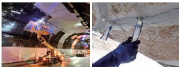
ひび割れ補修状況
