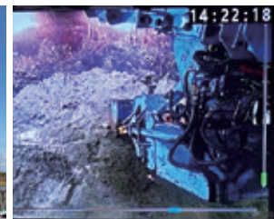
沈下掘削（無人掘削）
