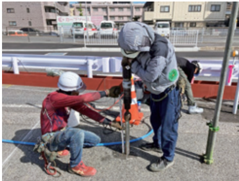
丸パイプ土中打込作業状況
