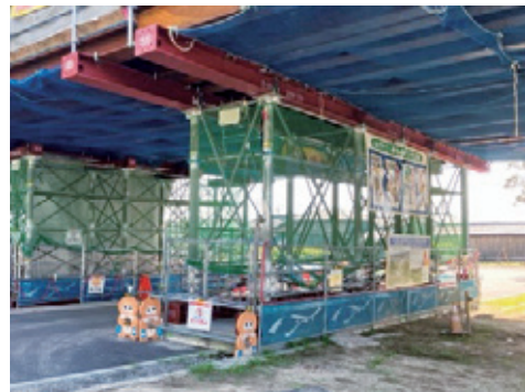
支柱支保（大型パイプ支柱）設置状況
