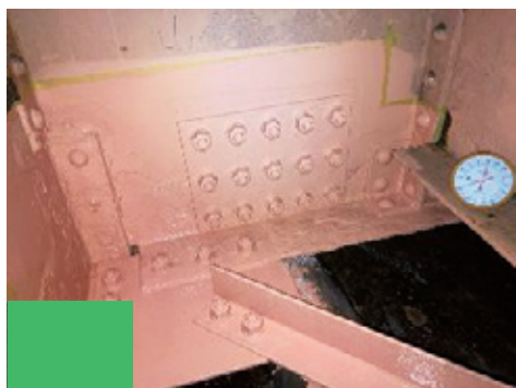
高力ボルト当て板鋼桁補強状況
