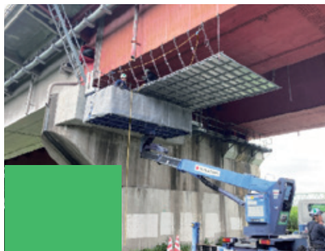
システム（パネル式）吊足場設置状況
