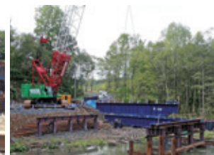
仮設鉄桁架設状況
