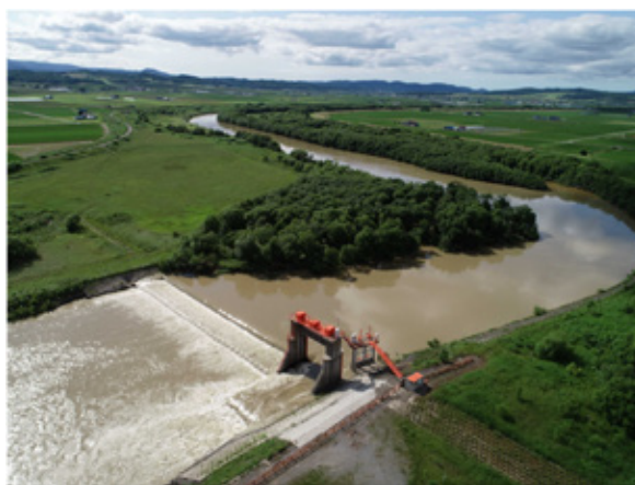
写真－1 旧頭首工
