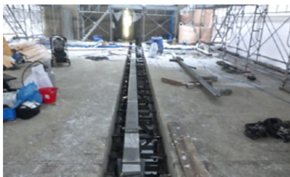
写真-11 下部戸当り据付
