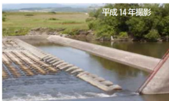
写真－2 旧頭首工の護床工低下
