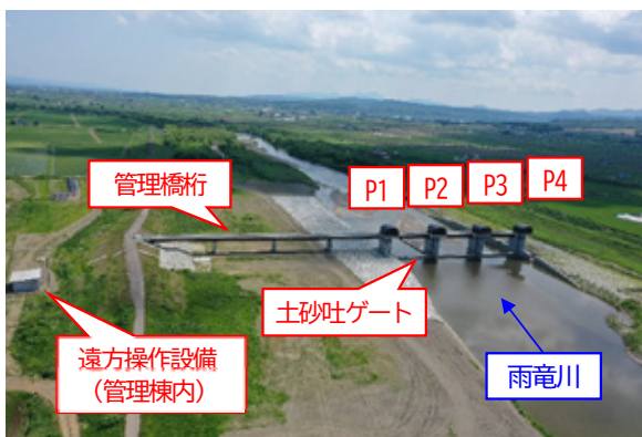
写真－９ 令和６年度施工全景（完成）
