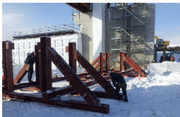
写真-13 扉体組立架台設置
