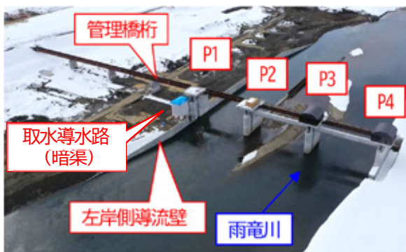
写真－７ 令和５年度施工全景
