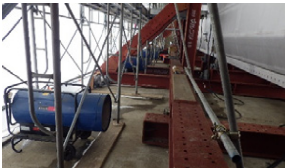
写真-20 仮囲い内養生
