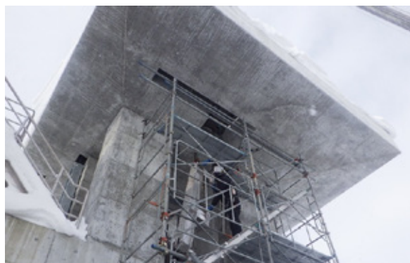
写真-12 側部戸当り据付
