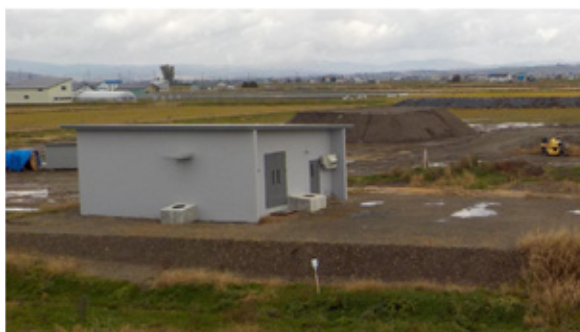
写真－８ 令和５年度施工管理棟
