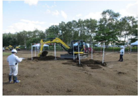
写真－８ バックホウ（Ｂ班）の試験実施状況
