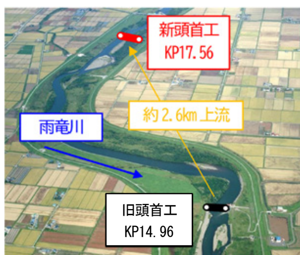
写真－3 新頭首工の建設位置
