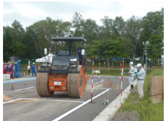
写真－１０ ロードローラ（Ｅ班）の試験実施状況
