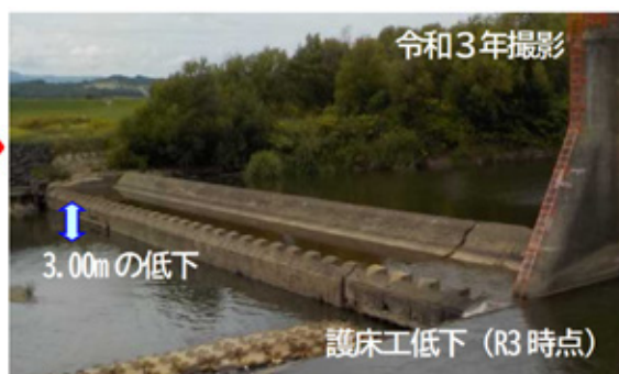
写真－2 旧頭首工の護床工低下
