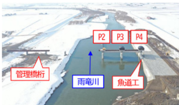
写真－６ 令和４年度施工全景
