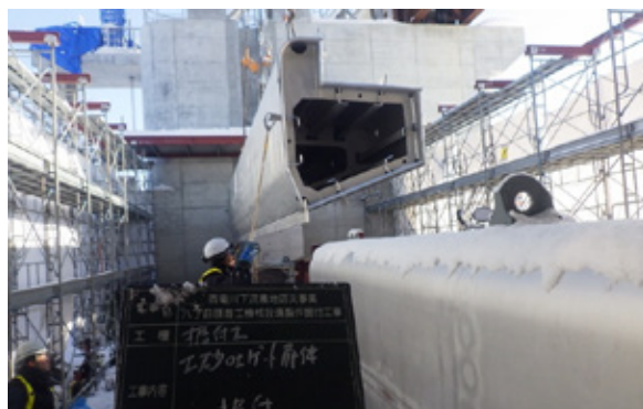
写真-14 扉体吊り込み・組立
