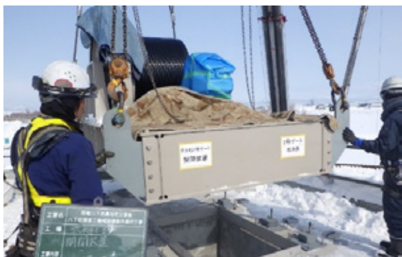
写真－16 開閉装置据付
