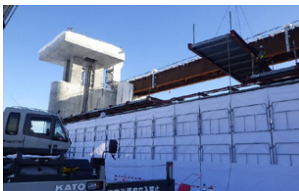
写真-10 仮囲い設置
