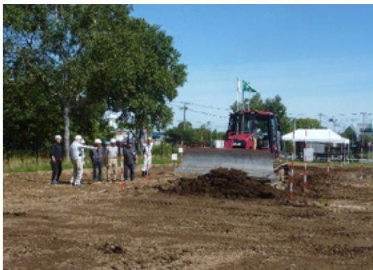
写真－７ ブルドーザ（Ａ班）の試験実施状況
