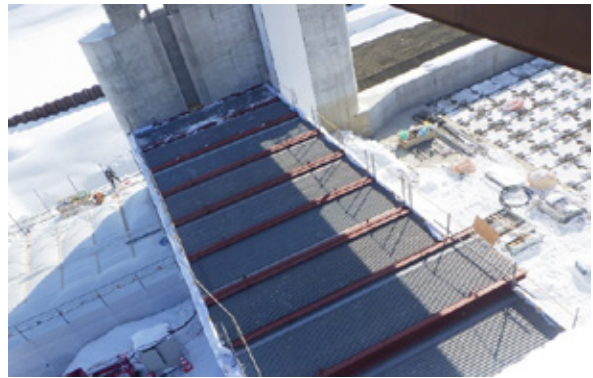
写真-22 開閉式仮囲い屋根（ADMパネル）
