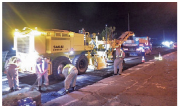
ICT路面切削機による切削状況
