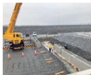
ブロック据付状況 (ラフテレーンクレーン)
