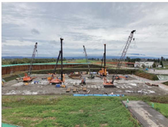
写真－３ 北村遊水地排水門工事
