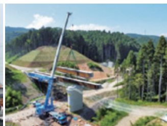
主桁架設施工状況
