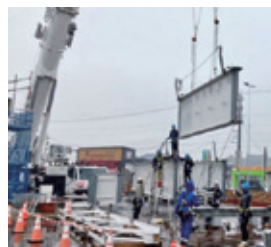
地組工施工状況
