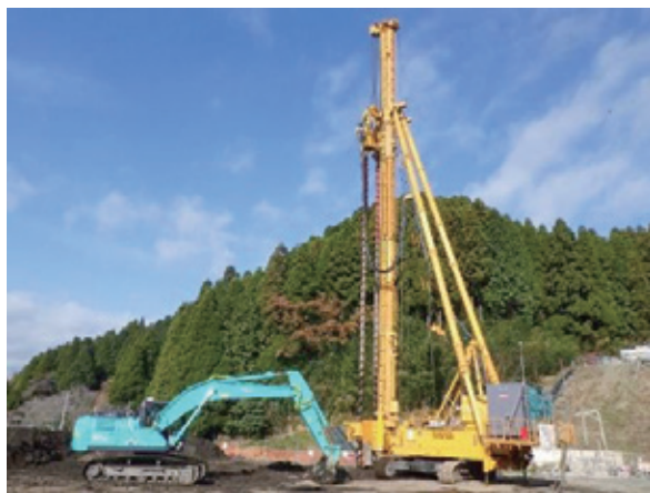
スラリー攪拌作業状況
