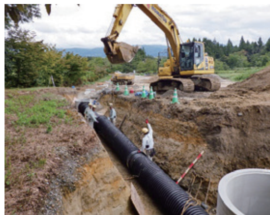
暗渠排水管設置状況
