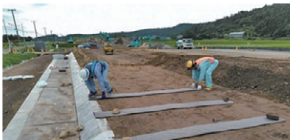
排水材設置状況
