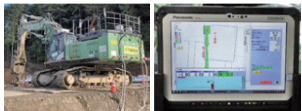
ICT中層混合処理機による攪拌混合
