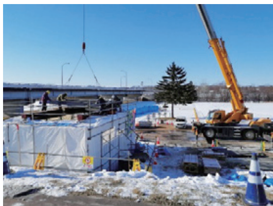
雪寒仮囲い（Wタイプ）設置状況
