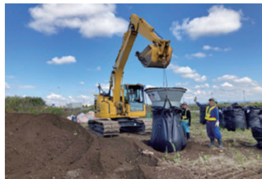
大型土のう製作状況
