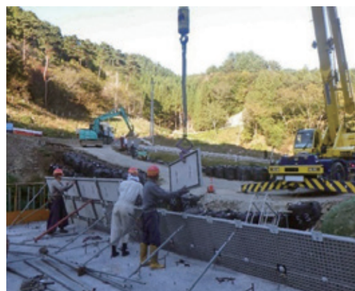
残存型砕組立・設置状況
