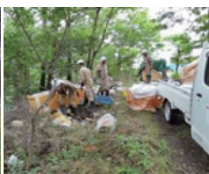
堆積塵芥収集状況
