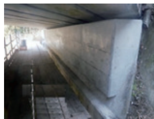
コンクリート打設状況
