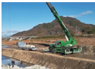
ブロック据付状況 (ラフテレーンクレーン)
