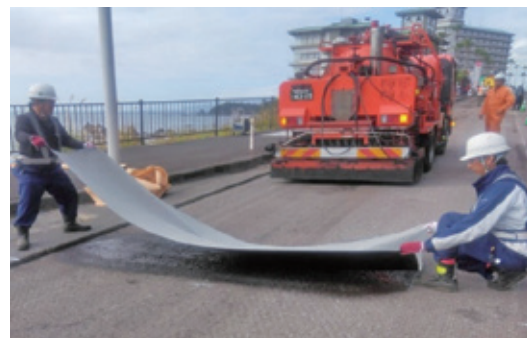
クラック防止シート張り作業状況
