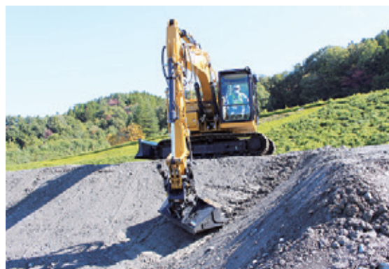
写真-3 チルトローテータによる法面整形
