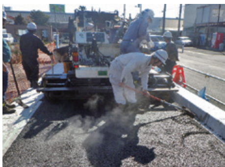
敷均し作業状況
