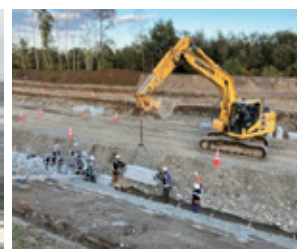
ブロック据付状況 (バックホウ)新規制定
