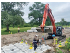
ブロック据付状況 (バックホウ)新規制定
