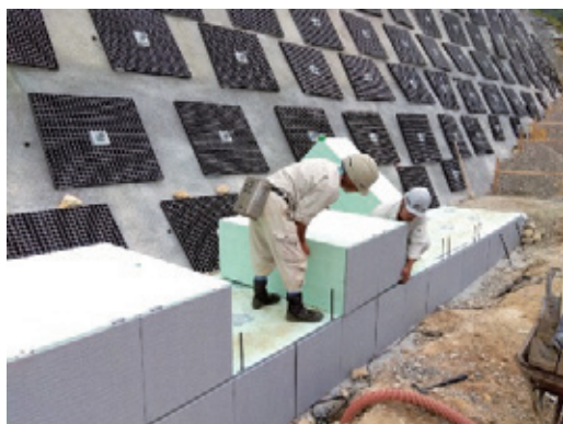
発泡スチロール設置状況
