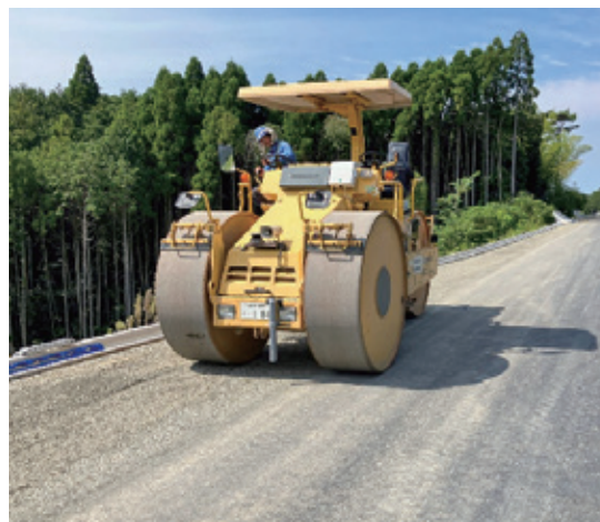
タイヤローラによる締固め作業
