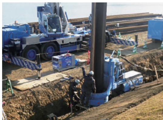
鋼矢板圧入状況
