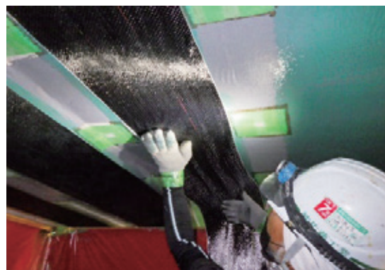
炭素繊維シート貼付状況
