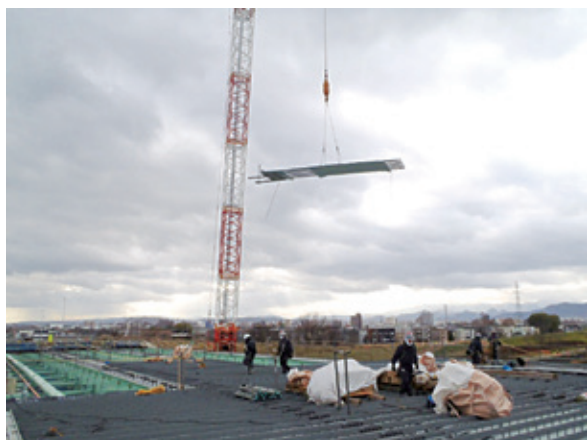
写真－15 床版パネル設置状況
