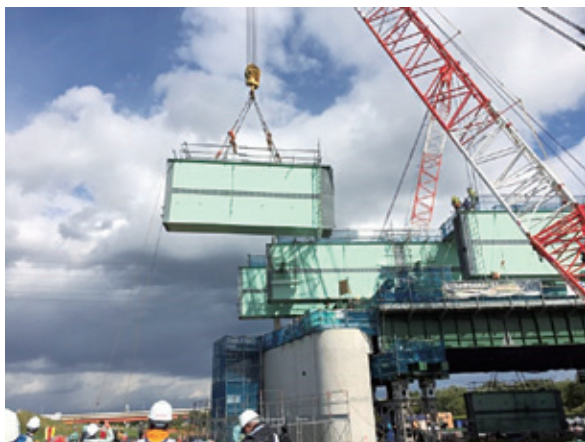
写真－11 クレーン架設状況
