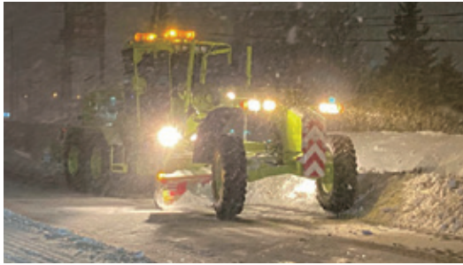
写真－7 検証試験除雪作業状況（2日目）
