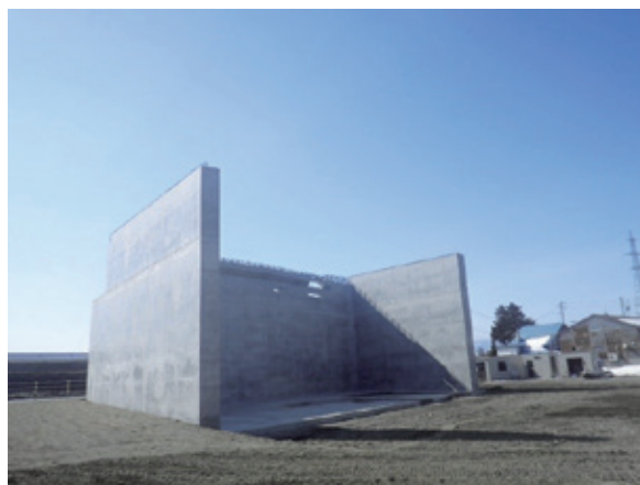
写真－４ A1橋台完成状況
