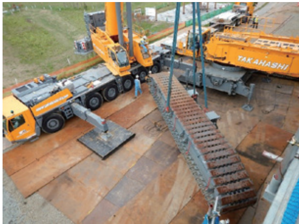
写真－9 500 t クレーン組立状況
