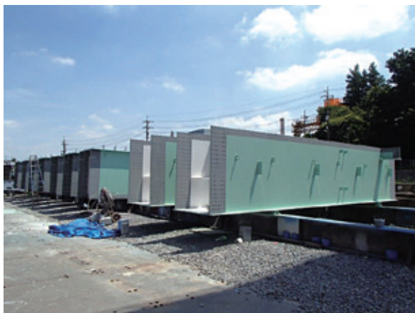
写真－8 桁製作完成状況
