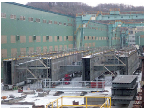
写真－7 仮組立状況
