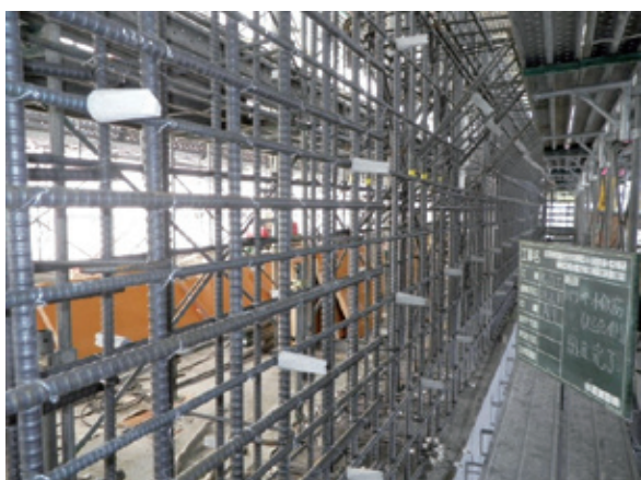
写真－３ 躯体施工状況（A1橋台）
