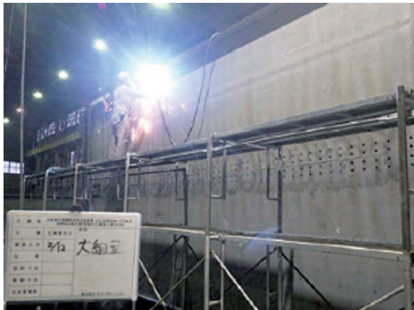
写真－6 桁製作状況
