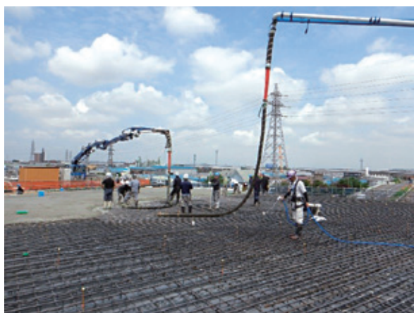
写真－16 床版コンクリート打設状況
