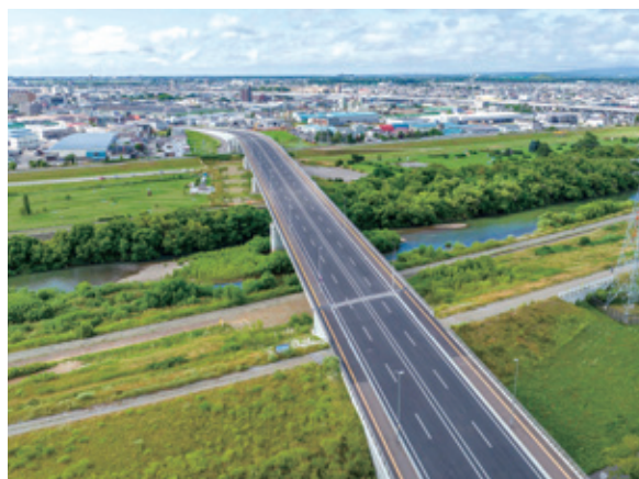
写真－18 橋梁完成状況
