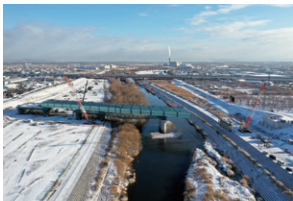
写真－12 送出し状況
