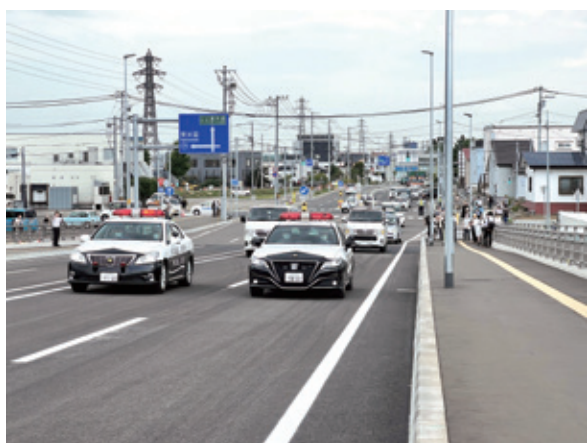
写真－21 橋梁開通状況-白石区側
