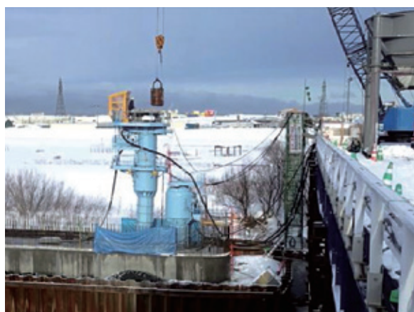
写真－５ 排土状況
