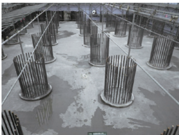
写真－２ 場所打ち杭施工状況（A1橋台）
