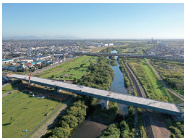
写真－17 床版コンクリート打設後全景
