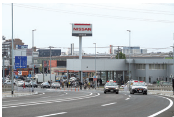
写真－22 橋梁開通状況-東区側
