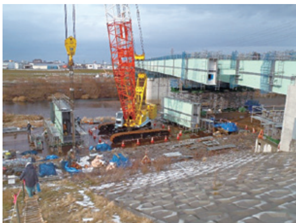
写真－10 地組状況
