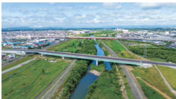
写真－１ 北24条桜大橋全景
