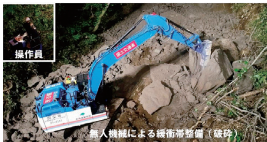
写真-4-1 分解組立型バックホウによる施工の様子
