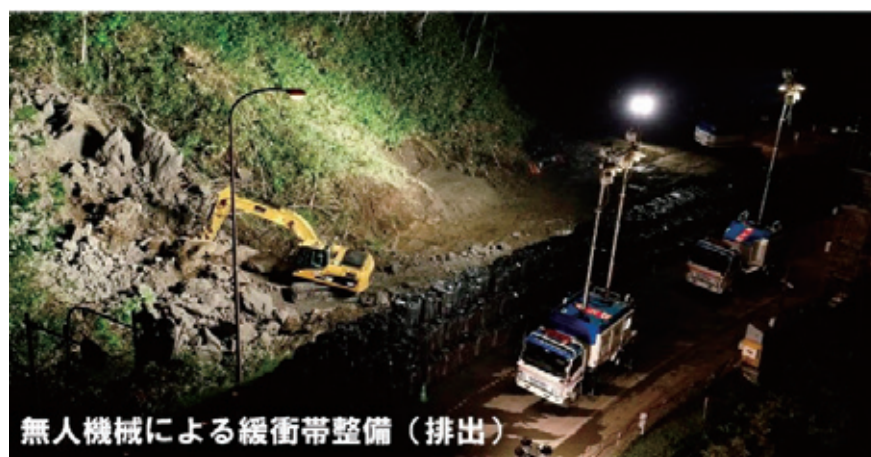
写真-4-2 簡易遠隔操縦装置を用いた無人機械による施工の様子
