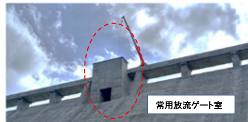
常用放流ゲート室
