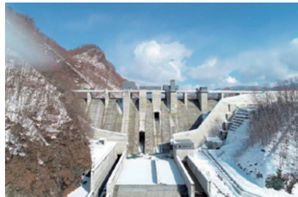
写真－1 平取ダム試験湛水状況(令和4年2月)
