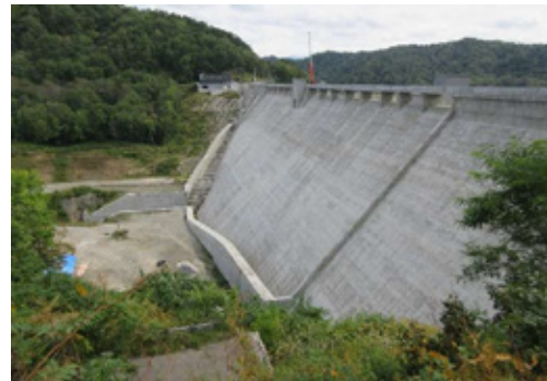
新桂沢ダム全景（左岸より）
