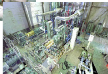
写真③-2 点群データ化された機場（内部）
