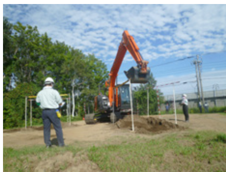
第2種(ショベル系建設機械)試験状況
