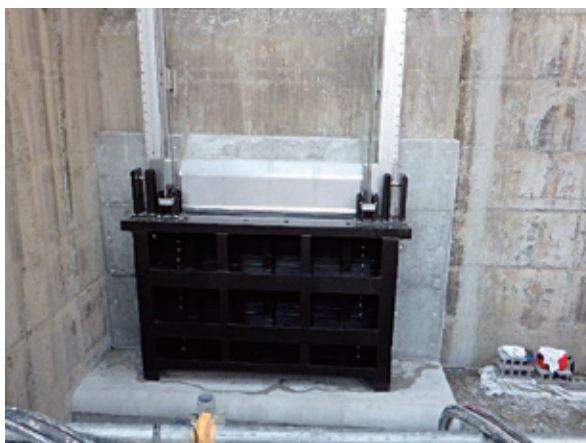
写真-6 魚道閉塞ゲート
