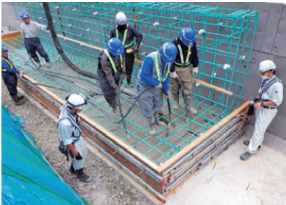
締固め作業（コンクリート工）
