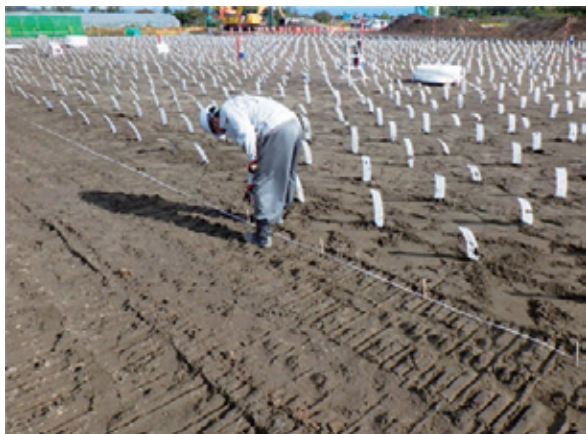
ドレーン施工後状況
