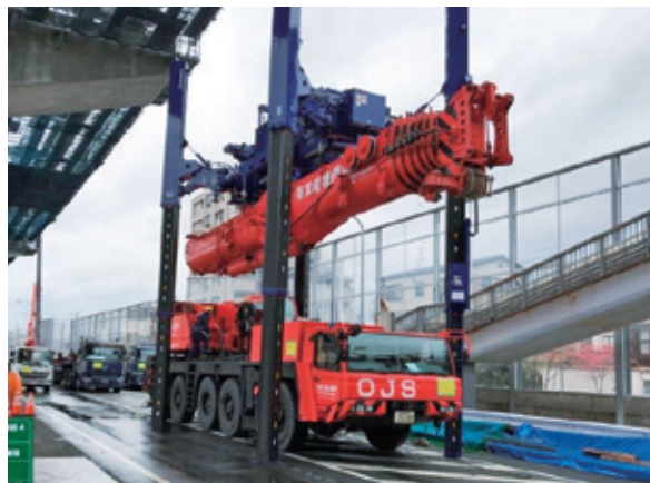
リフターによる作業（オールテレーンクレーン）
