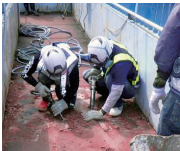
既設舗装はぎ取り状況（横断歩道橋補修工）
