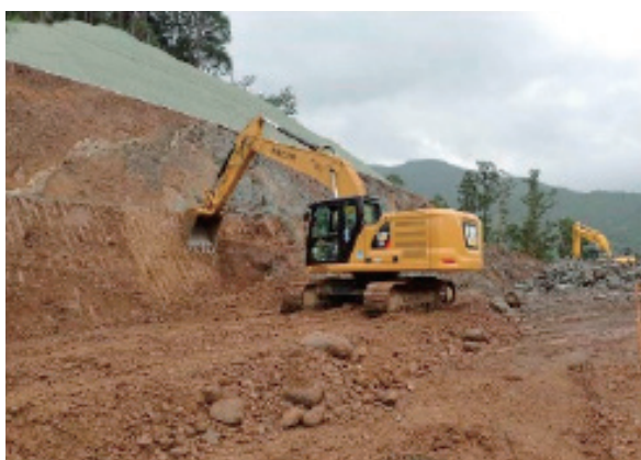
3D-MGバックホウによる作業状況
