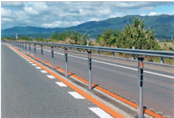
ワイヤロープ全体状況
