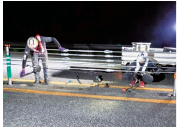
ターンバックル設置作業状況
