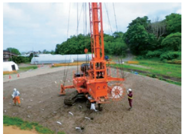
施工機械による打設状況
