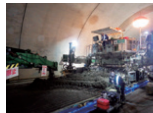
コンクリート二層同時施工
