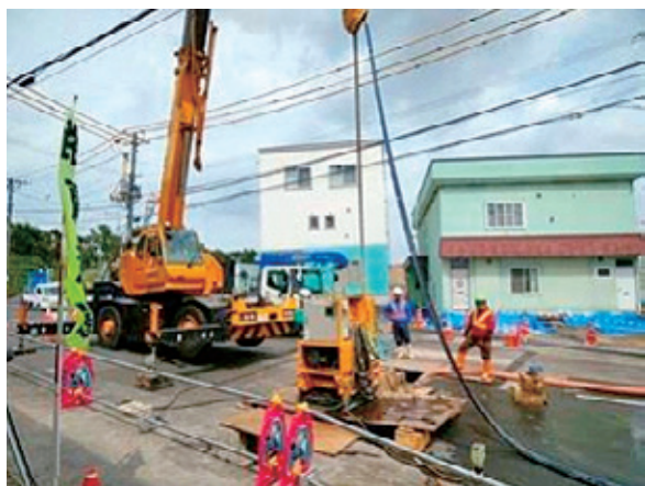
施工状況（二重管工法）
