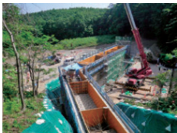
南の沢川渓流堰堤外工事
