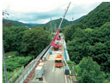
錦橋架換工事
