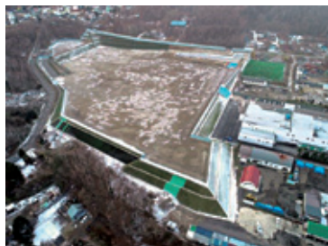
駒岡清掃工場更新事業敷地造成工事
