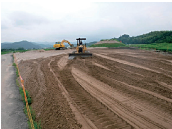
ブルドーザによる敷均し作業
