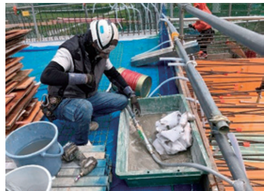
グラウト注入状況
