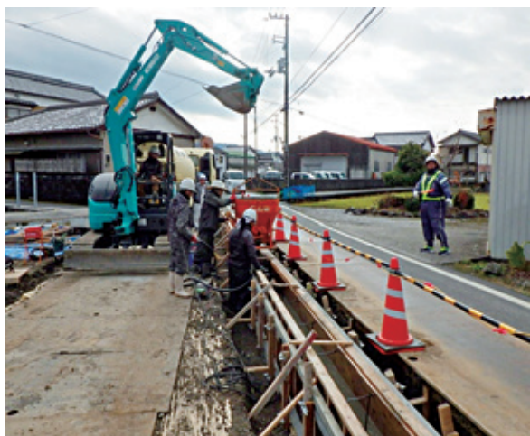
バックホウのバケットによる コンクリート打設作業状況
