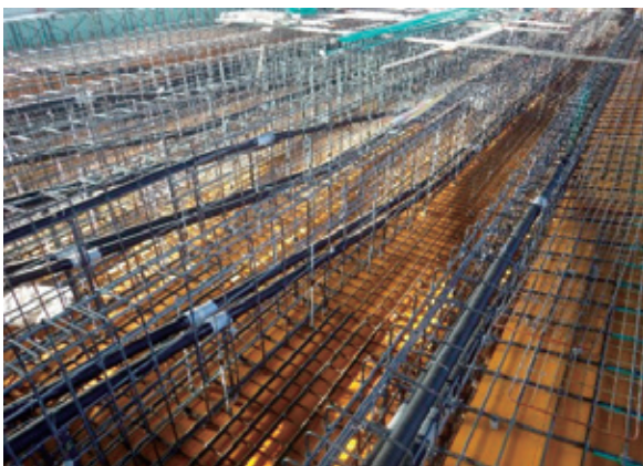
PCケーブル挿入状況
