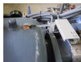
写真-7 ポンプ主軸軸受加速度計
