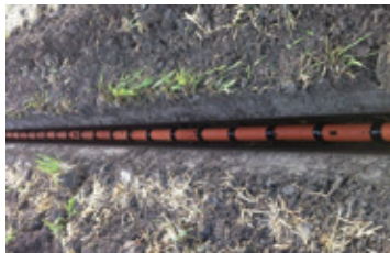
(写真) 素焼土管用ソケットの設置状況
