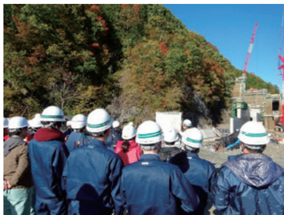
沙流川ダム建設事業所長原えん堤班長からの説明
