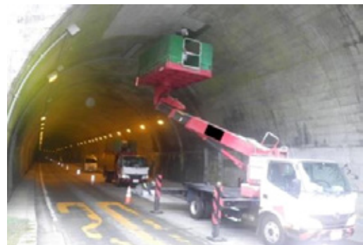
注入材の注入状況（全景）
