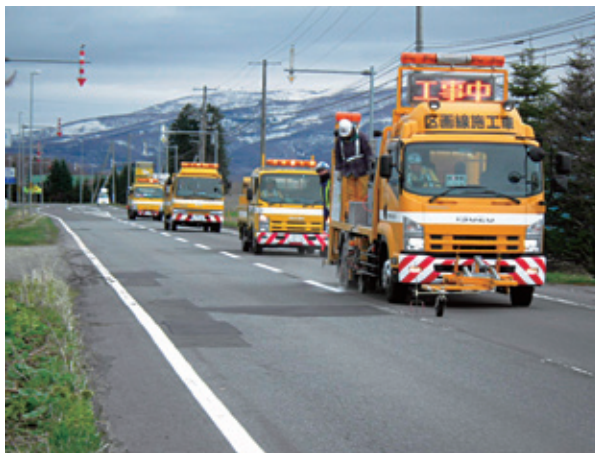
一般国道37号洞爺湖町外区画線工事
