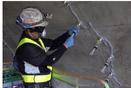
注入材の注入状況
