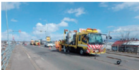
一般国道233号 区画線設置
