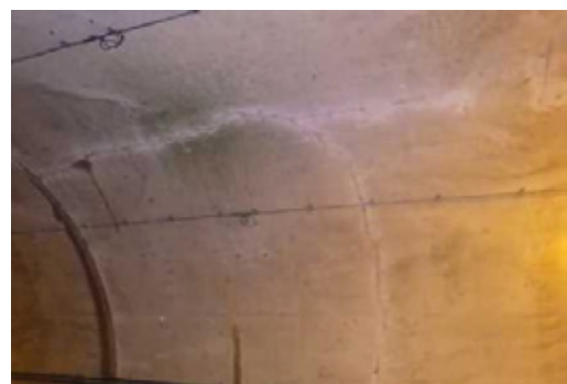
施工完了（補修完了）
