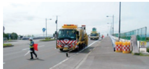
一般国道231号 区画線設置
