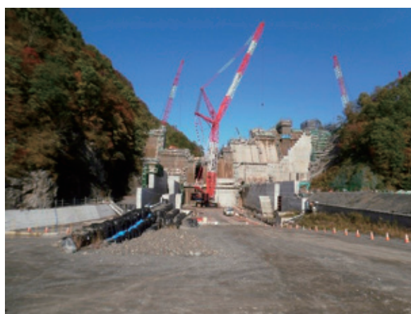
平取ダム下流側からの建設状況
