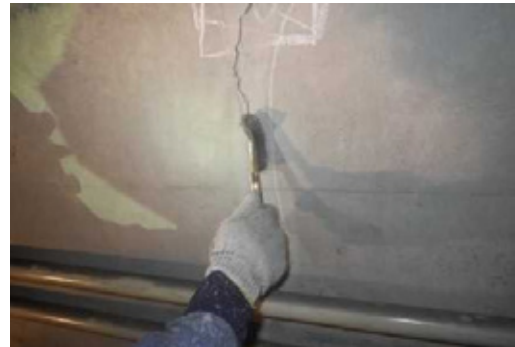
ひび割れ部の清掃
