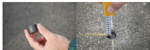
写真-2 磁気マーカ埋設状況
