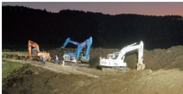
遠隔操作式バックホウによる啓開作業（厚真川）
