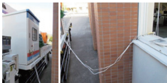
排水ポンプ車による電源供給（蘭越町役場）
