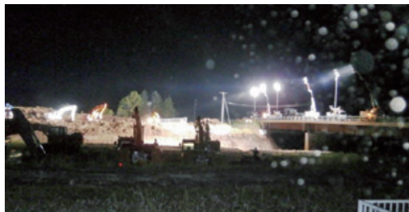
照明車による作業支援（厚真川）
