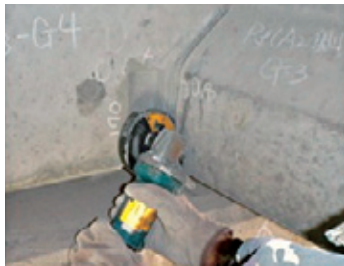
ひび割れ補修工(充てん工法) ひび割れ面のカット状況
