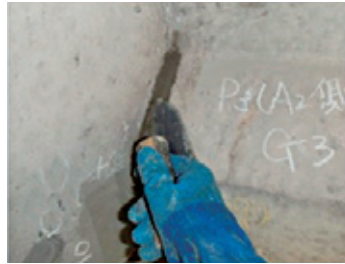
充てん材の充てん状況
