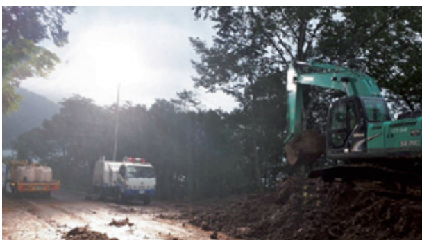
照明車による作業支援（国道453号千歳市）
