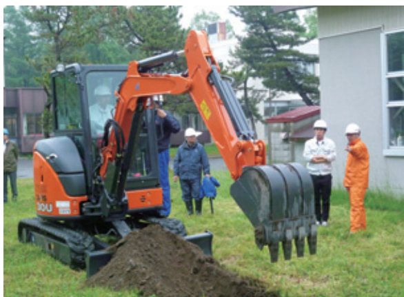
写真－8 ICT建機体験試乗 (苫小牧高専・日立建機日本㈱担当)
