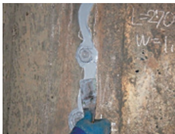
ひび割れ補修工(低圧注入工法) シール材の塗布状況
