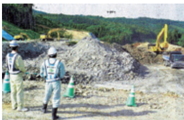
ICT建機施工状況 (大平東改良工事)
