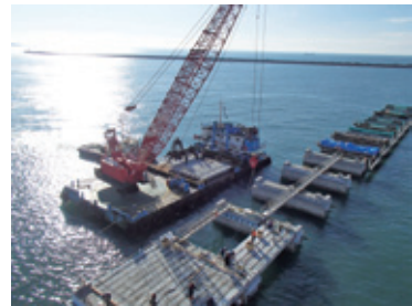
釧路港 岸壁建設
