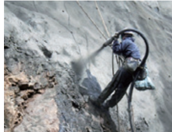
仮設用モルタル吹付工 (吹付状況)
