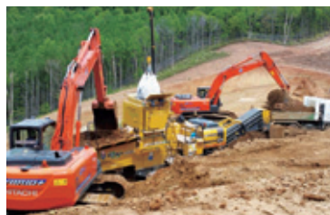
リテラ施工状況 (忍路工事)
