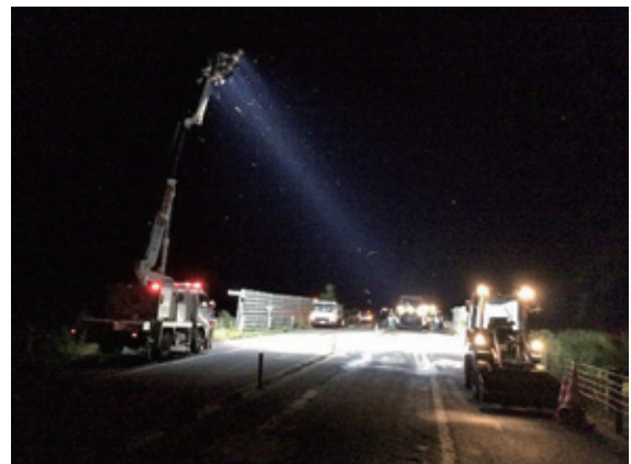
照明車による作業支援（日高自動車道）
