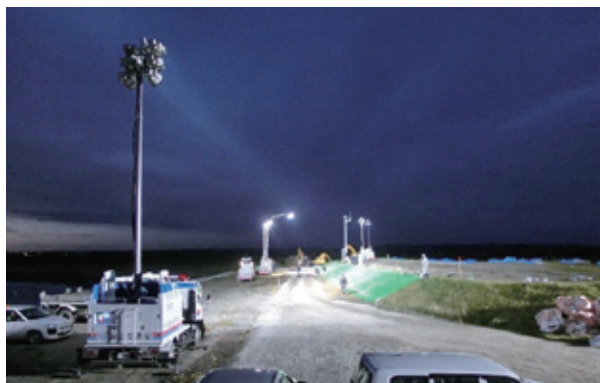
照明車による作業支援（むかわ町鵠川）
