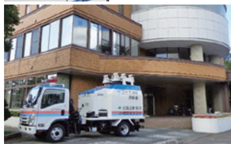
照明車による電源供給（蘭越町役場）
