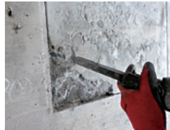
断面修復工(左官工法) はつり状況
