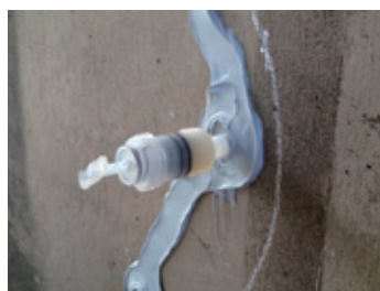
補修材の注入状況
