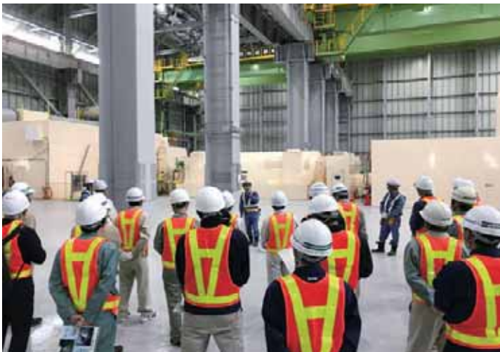
1号機タービン建屋内
