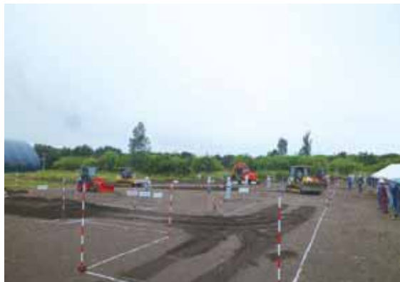
建設機械施工技術検定実地試験
