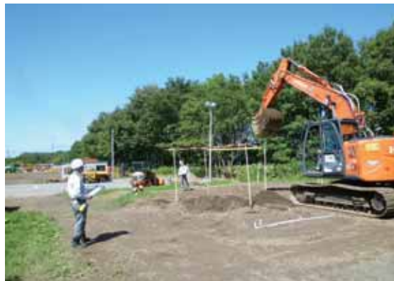
第2種（ショベル系建設機械）試験状況
