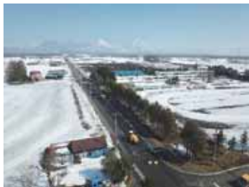
一般国道38号清水町清水舗装補修外一連工事
