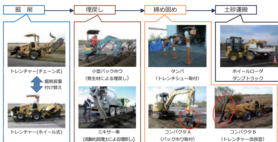
図-2 試験フロー及び使用機械の外観
