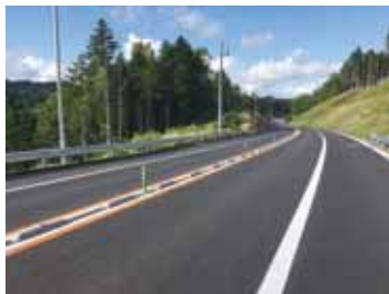
北海道横断自動車道訓子府町美園東舗装工事
