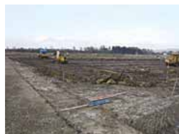
経営体東滝川第1地区64工区
