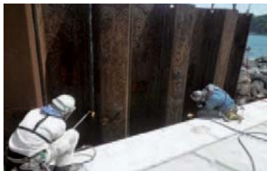
ガス切断状況
