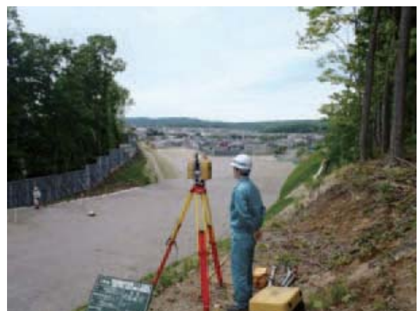
写真2 3次元測量状況
