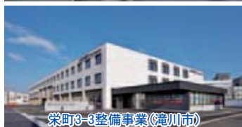
栄町3-3整備事業(滝川市)
