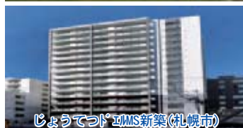
じょうてつⅡMMS新築(札幌市)
