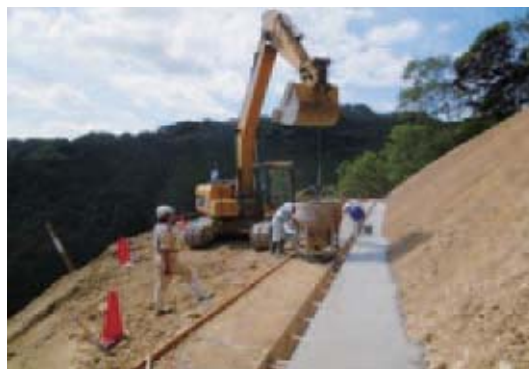
小段排水溝打設状況
