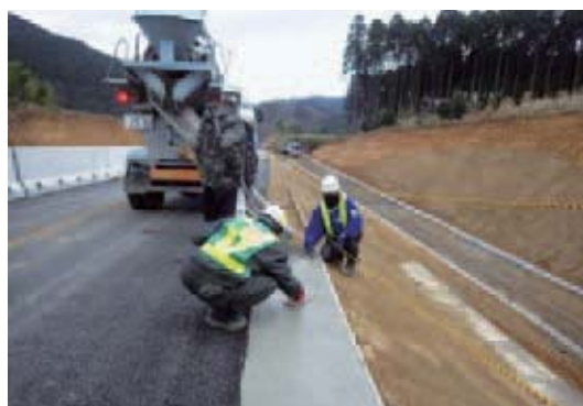
防草コンクリート打設状況
