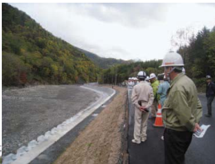
岩瀬橋付近の復旧状況見学
