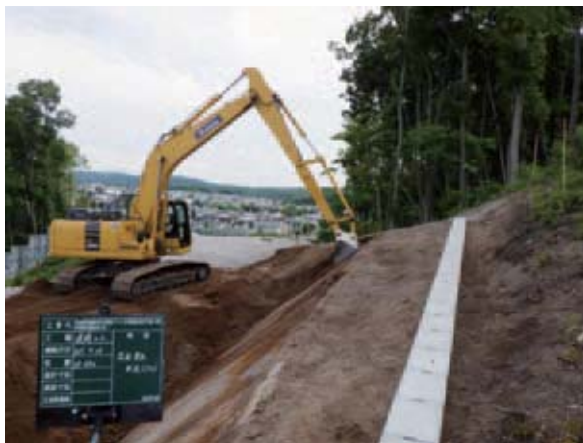
写真1 ICT活用工事施工状況
