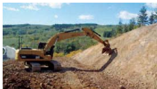
法面整形作業状況 (ICT)
