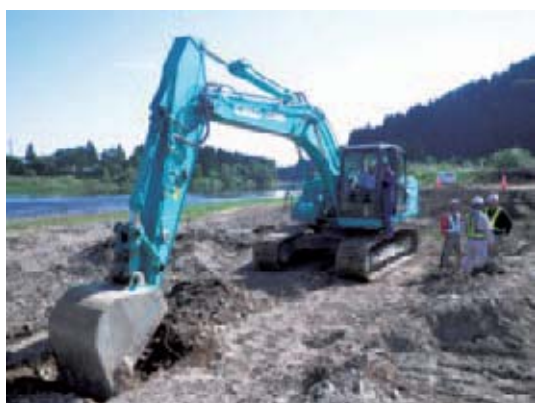
土砂掘削状況 (ICT)
