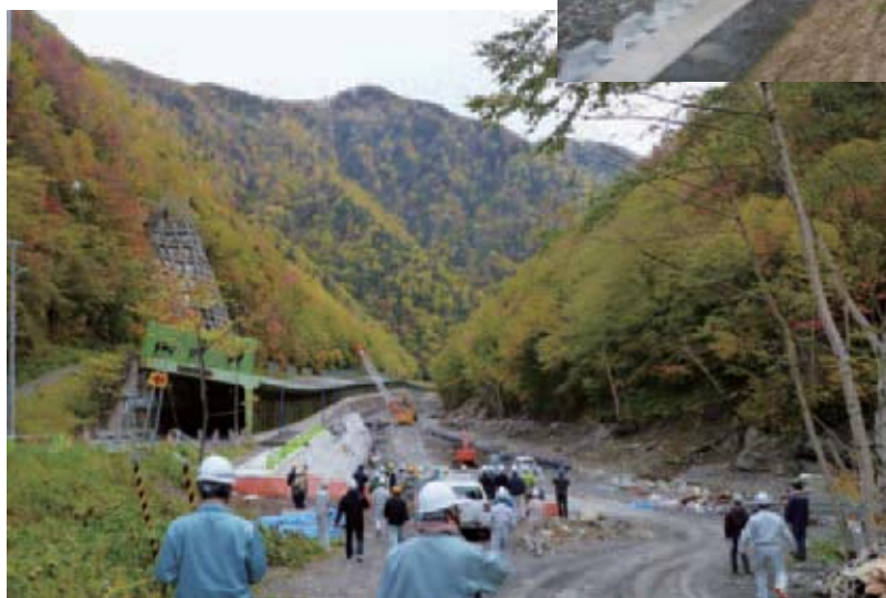
清瀬覆道の復旧状況見学
