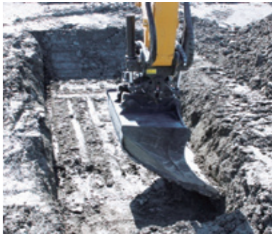
写真－５ チルトローテータによる溝整形
