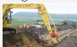
掘削積込 法面整形
