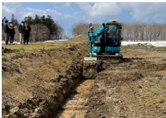
写真5 (オフセットブームでの掘削状況)
