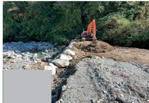
土砂による仮締切設置作業状況
