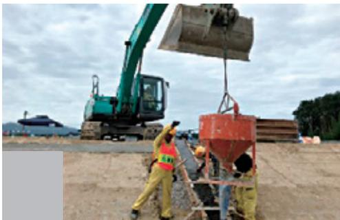
小口止工コンクリート現場打設状況
