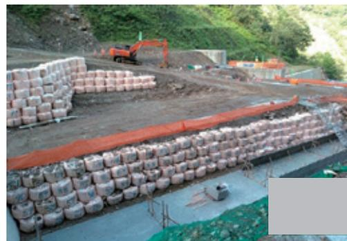
大型土のうによる仮締切設置状況
