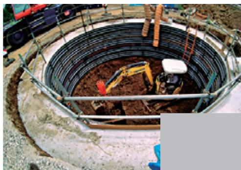
小型バックホウによる掘削状況
