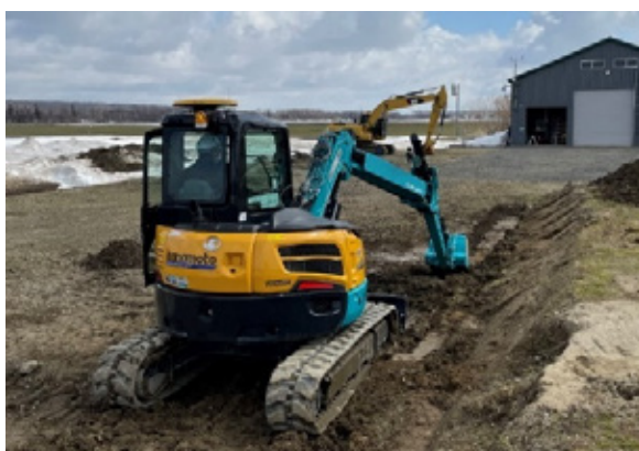
写真6 (オフセットブームでの掘削状況) (後方から見た掘削作業風景)
