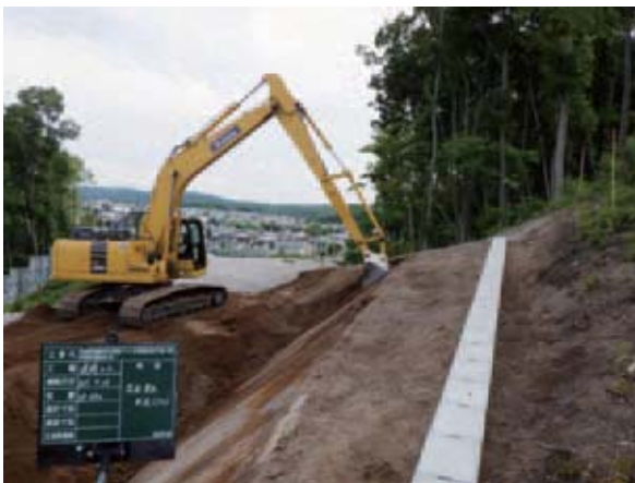
写真1 ICT活用工事施工状況
