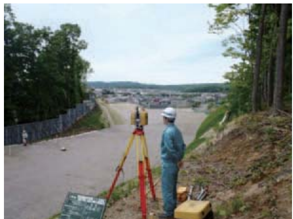
写真2 3次元測量状況
