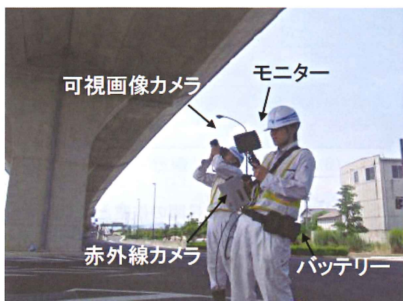
写真-12 非破壊検査技術（橋梁）
