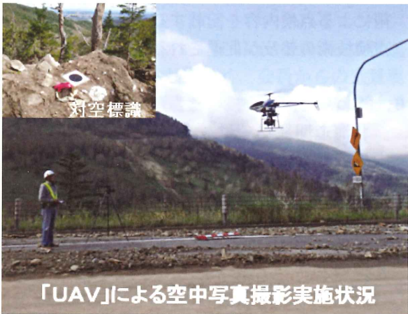
写真-8 UAV (RCヘリコプター型) による空中測量
