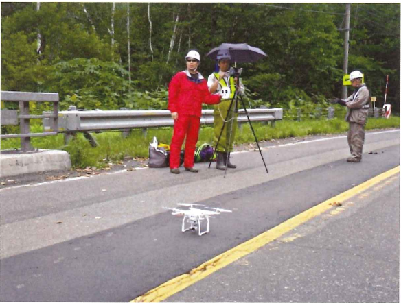
写真-9 UAV (小型ドローン型) による空中測量
