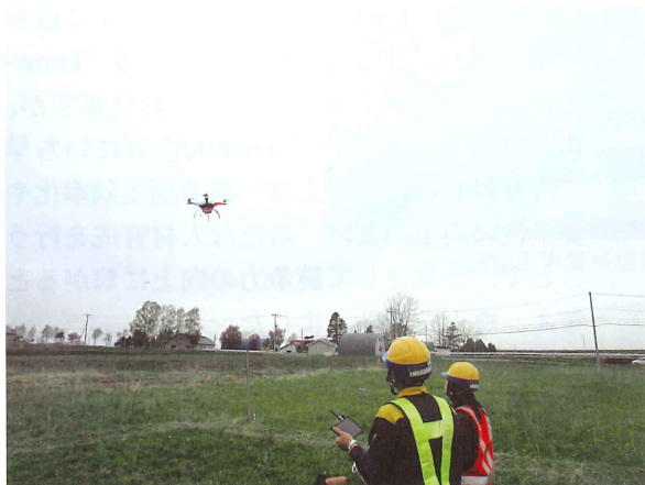
写真3 UAVによる起工測量
