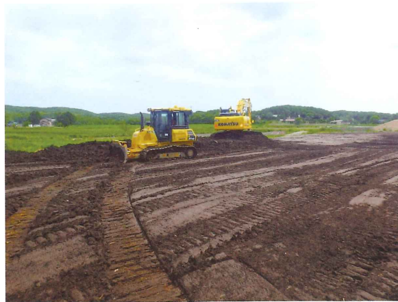
写真4 ICT建機による施工状況
