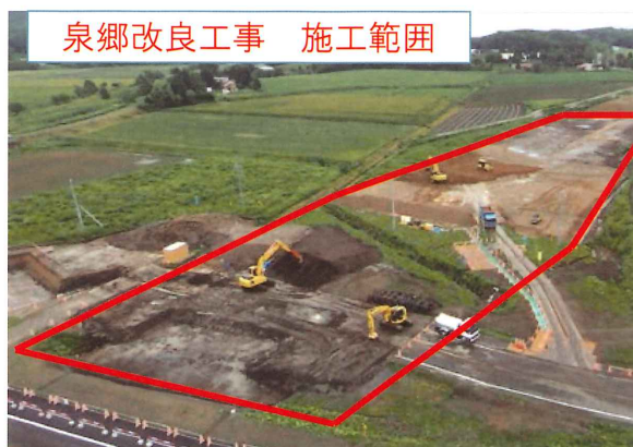
写真1 泉郷改良工事の全景
