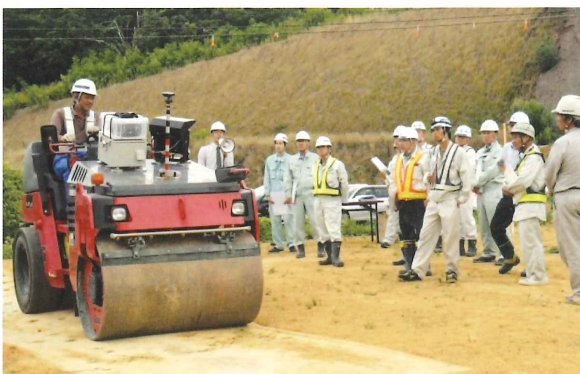
写真-6 TS・GNSS締固管理
