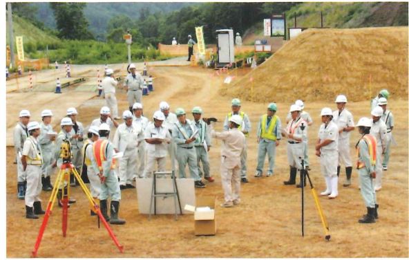
写真-7 TSによる出来形管理
