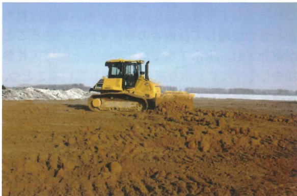
写真1-3 整地(枠内:仕上げ進捗マッピング)
