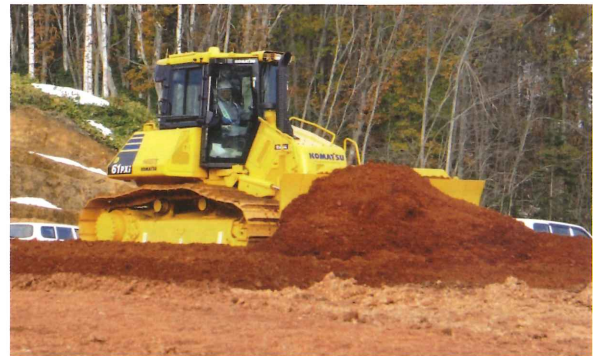
写真2-2 敷均、仕上整地で稼働するD61PXi-23
