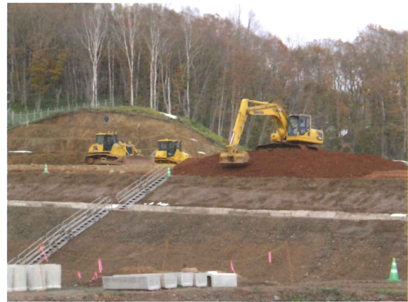
写真2-1 路体盛土現場
