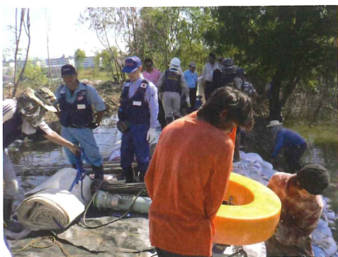
排水ポンプ設置作業の指導状況 （中央が川端専門官）
