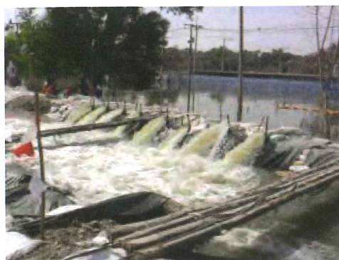
排水ポンプ車による排水状況
