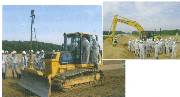
写真-1 ブルドーザマシンコントロール技術（右上は油圧ショベルマシンガイダンス技術）
