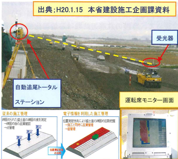
写真-2 TS・GPS振動ローラによる締固め施工例
